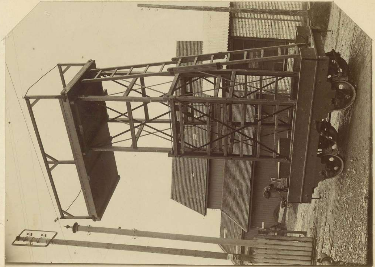
? Kom. 53 - Zug- und Floßverrichtung am Montage-Turmwagen der Limmattal-
