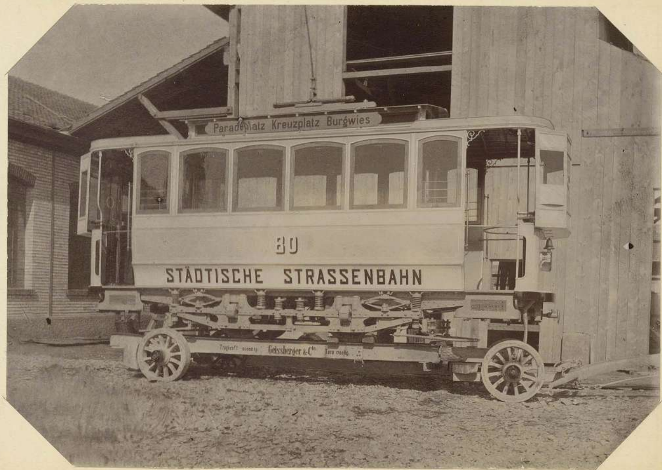
Trammotorwägen Ce 2 1/2 80 der St. St. Z, Baujahr 1899
